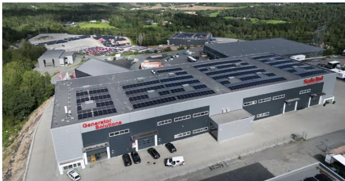
BÆREKRAFT: Ti bedriften i Røyken Næringspark har installert solceller på taket. | Foto: Medvind Eiendom
