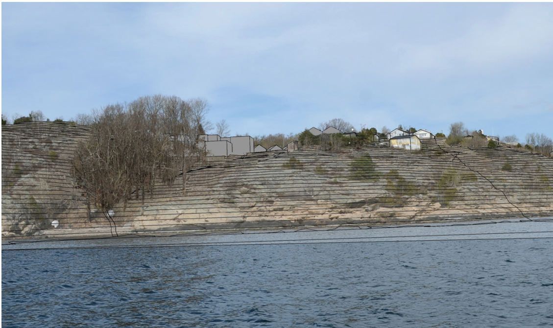
Figur 4 Planområdet sett fra fjorden med volumer som viser tillatt høyde og plassering
