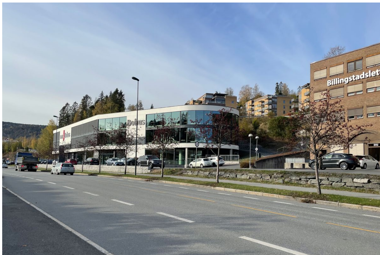
Figur 1 Foto av eksisterende bygg, sett fra sørøst
