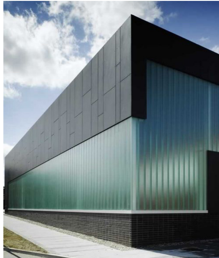
Enslartet platekledning med glassflater
