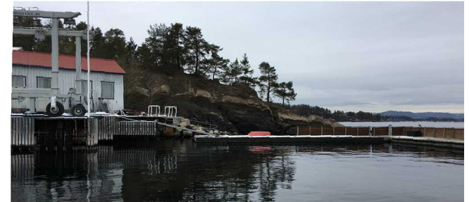
Fig. 16: Naturområdet er synlig i bakkant av bebyggelsen når planområdet sees fra sør-øst.
