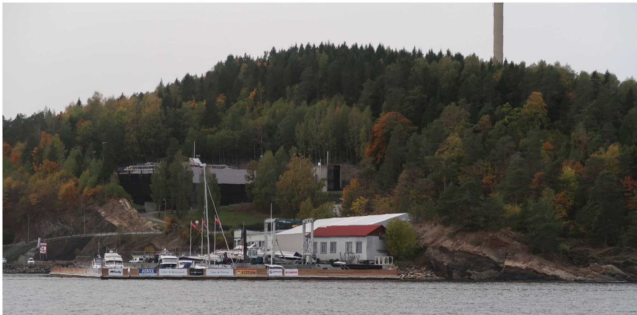
Fig. 17: Planområdet sett fra øst, som viser det bølgende landskapet og landskapsryggen planområdet ligger inntil.
