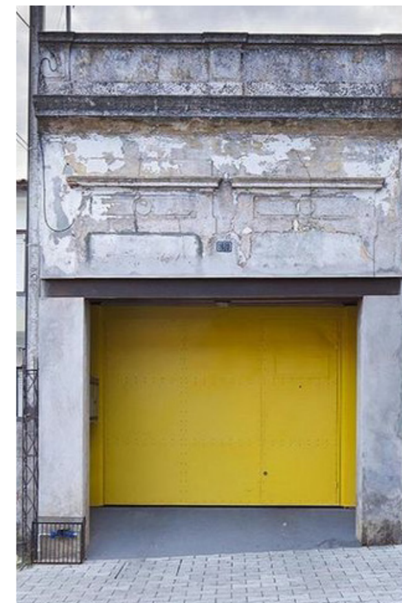
Betongvegg med kontrasterende dør/port
