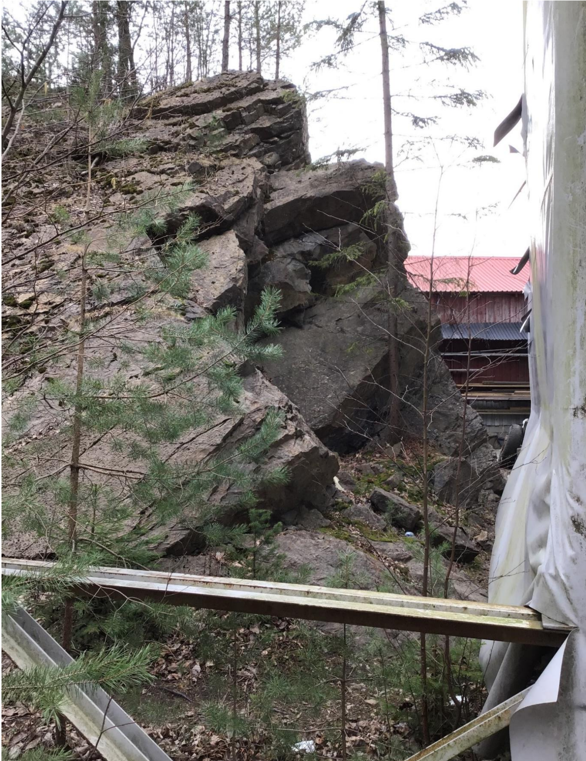
Figur 7: Skrå bergvegg mot plashallens østvegg (kortveggen). Blikk mot sør.
