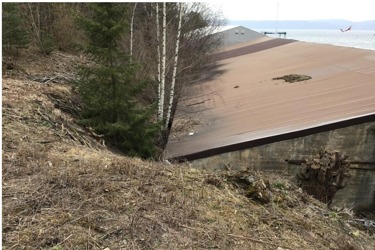
Figur 4: Kontorbygningens plassering i forhold til terrenget sett i fra vest mot øst.
