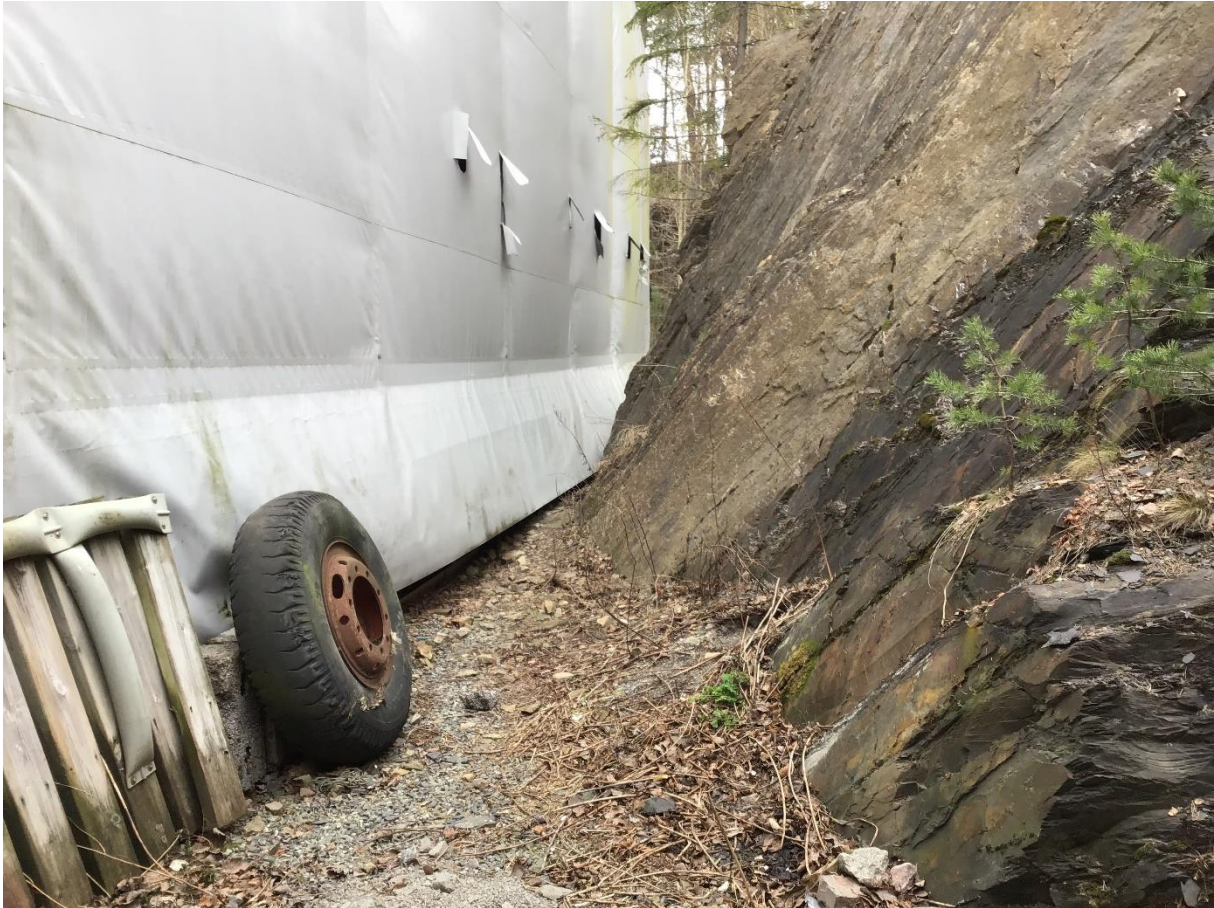
Figur 6: Skrå bergvegg mot plasthallens østvegg (kortveggen). Blikk mot nord.
