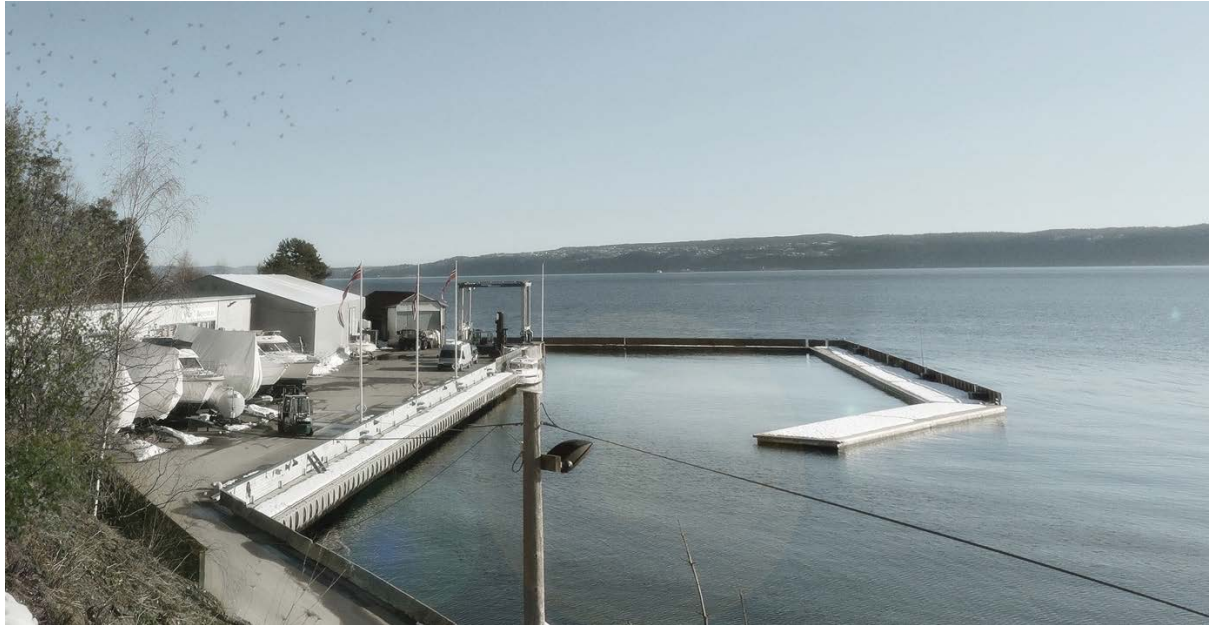
Fig 20: Bjerkåsholmen 115 sett fra vest. Eksisterende situasjon
