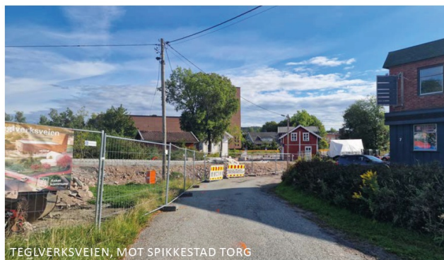
TEGLVÆRKSVEIEN, MOT SPIKKESTAD TORG
