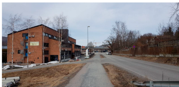
Eksisterende bygg sett fra sør, 3 etasjer
