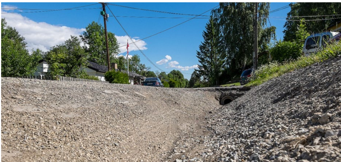
Figur 10 Rehabiliterert grøft. Foto: Tove Lauluten
