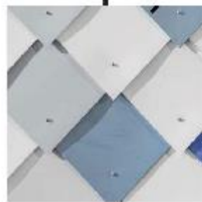
FISKESKJELL Fasadeplater, ombruk
