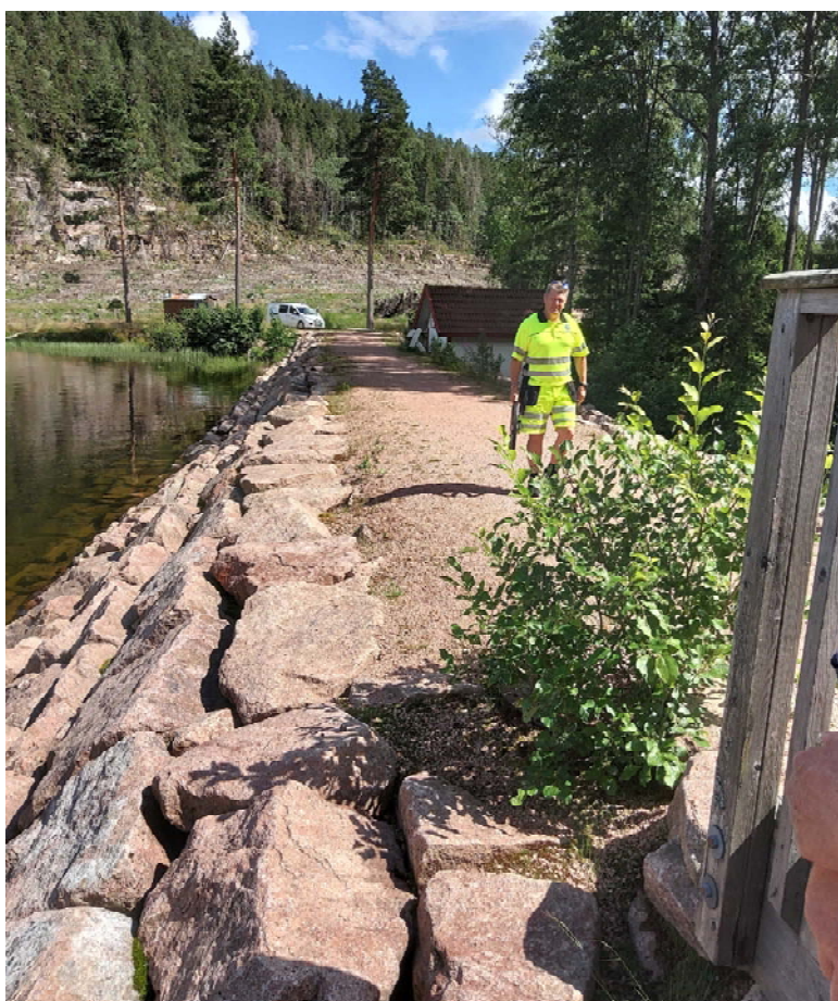
Figur 4-2: Eksempel på rehabilitert demning i høy klasse, Ebbestad-dam. Foto: Elin Hønsi (VTA)
