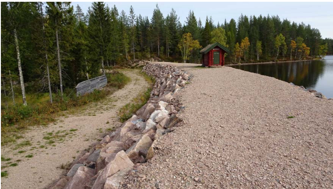
Figur 4-4: Eksempel på rehabilitert demning med plastring, Ulevann. Foto: Elin Hønsi (VTA)
