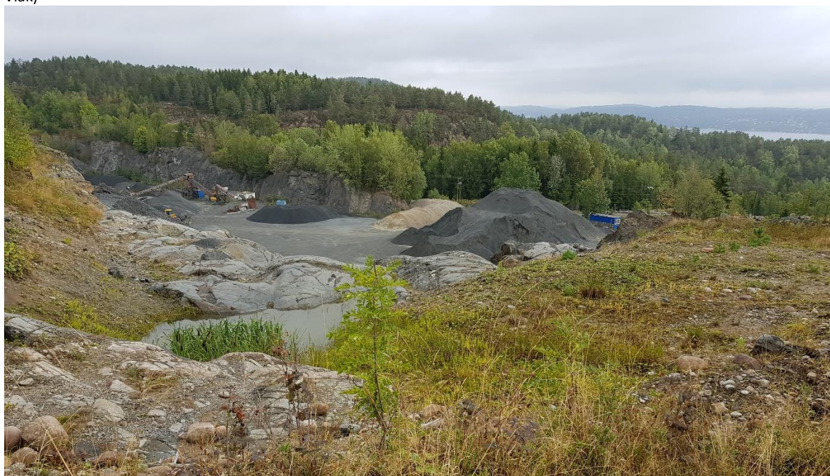
Figur 4-8: Pukkverket sett fra sør. (Foto: Asplan Viak)
