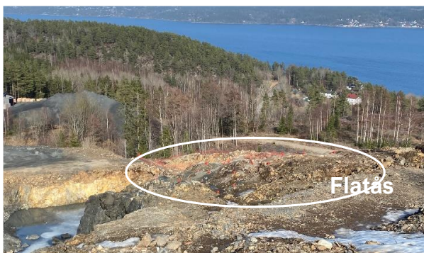
Figur 16: Område (tilsv. som markert i figur 15) markert med hvit strek viser plastplugger i borehull. Foto: Bjarne Blikeng 30.03.2021
