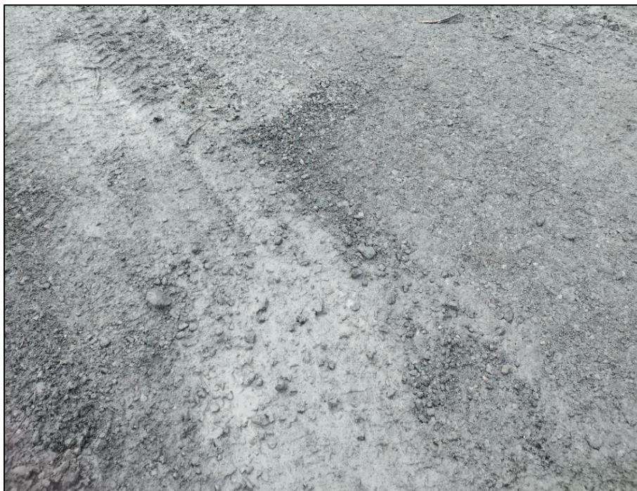
Figur 2-3: Grusdekke i Husebyveien
