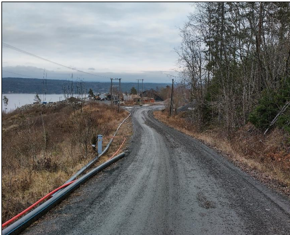
Figur 2-1: Husebyveien rett øst for pukverket
