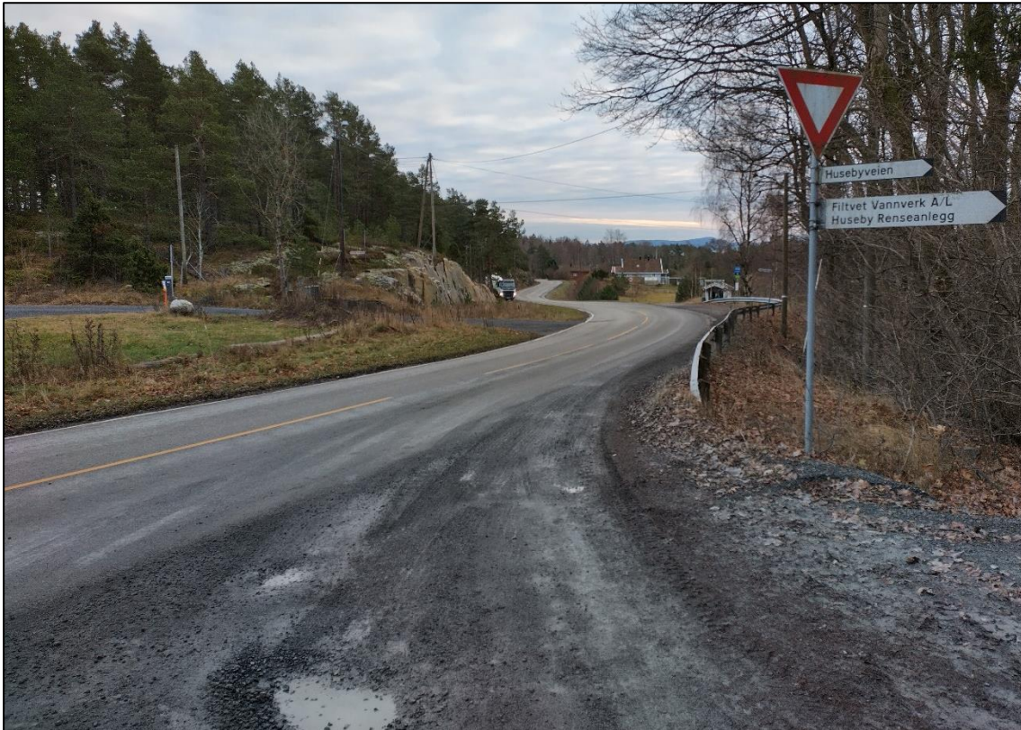
Figur 2-7: Krysset Husebyveien fv. 281 i retning sør (Asplan Viak)
