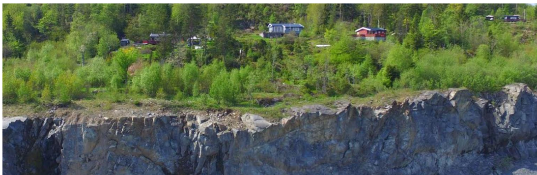
Figur 7: Sprekkdannelse i bruddet medfører ras. Foto: Bjarne Blikeng.
