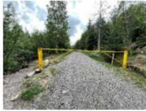
Figur 3.5.1: Bom ved starten av Stikkvannsveien
