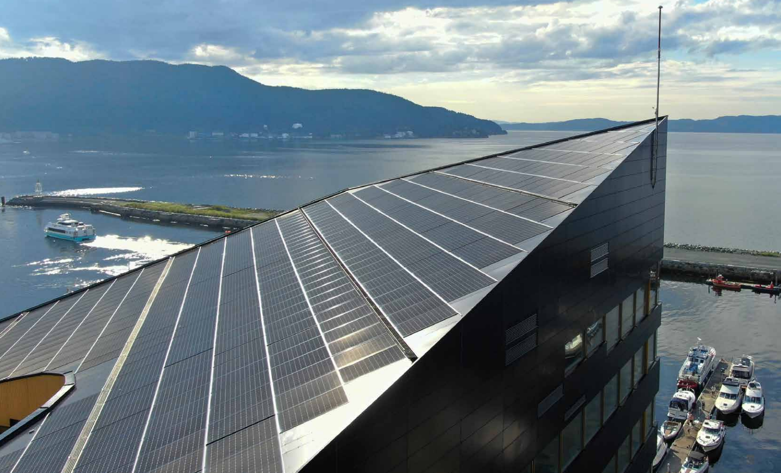
Powerhouse Brattørkaia i Trondheim har integrerte solcellepaneler på tak og fasade. (Foto: Solcellespesialisten)
