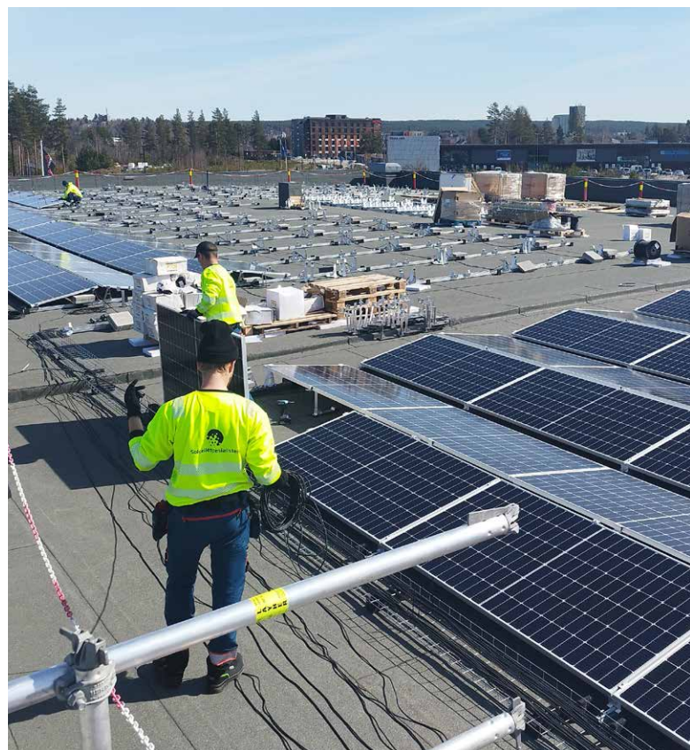
Montering av solcelleanlegg. (Foto: Solcellespesialisten)
