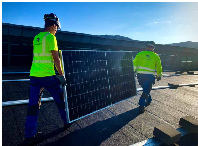
Montering av solcelleanlegg. (Foto: Solcellespesialisten)
