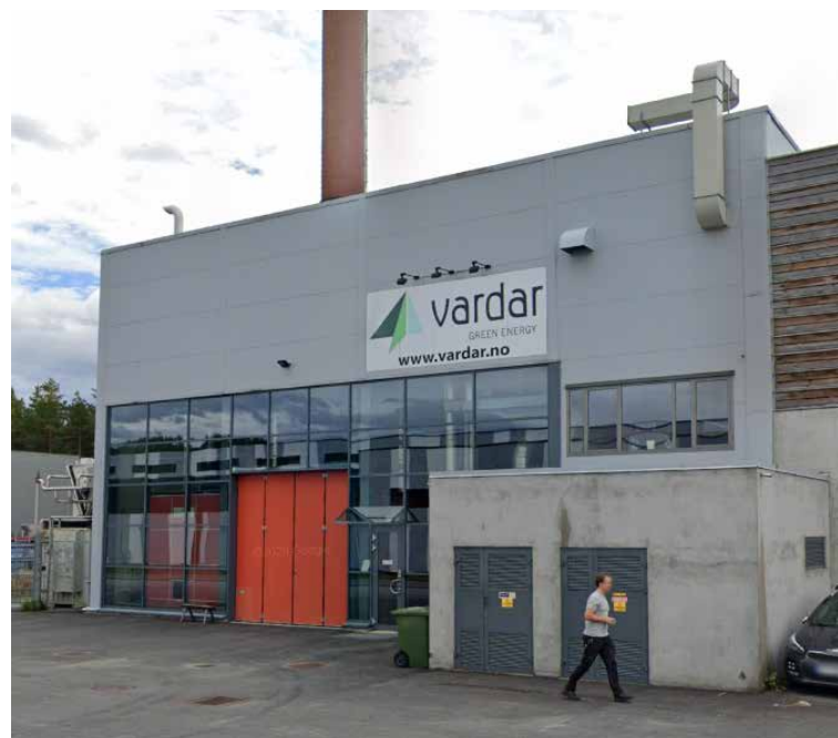
Varmesentralen på Hønefoss. (Foto: Vardar varme)
