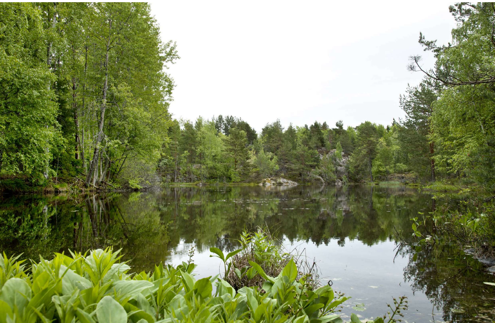
Buksedammen ved Spro, på vestsida av Sproveien, er en tidligere isdam med oppmurt demning, som ble anlagt i perioden 1860-1890. Foto: Øivind Møller Bakken
