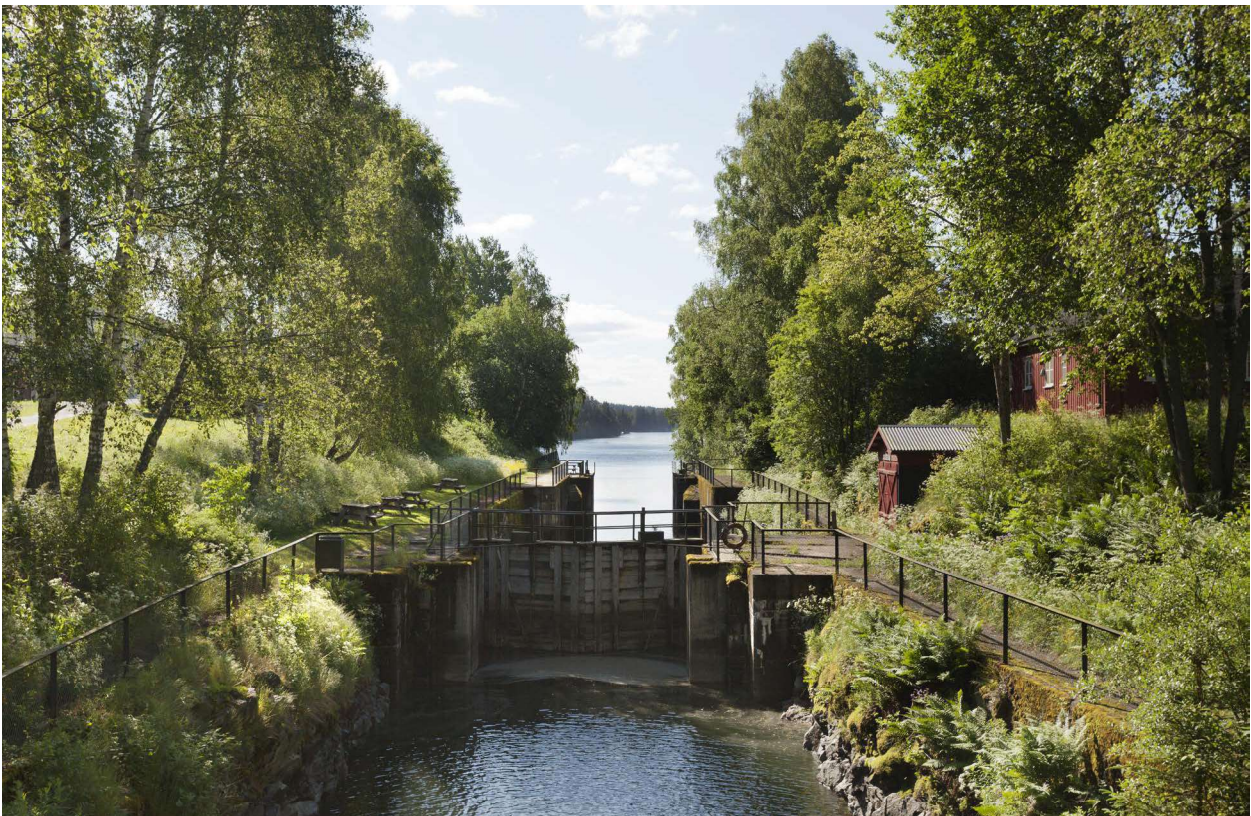
Svanfoss sluser i Vormo åpnet i 1912. Foto: Øivind Møller Bakken
