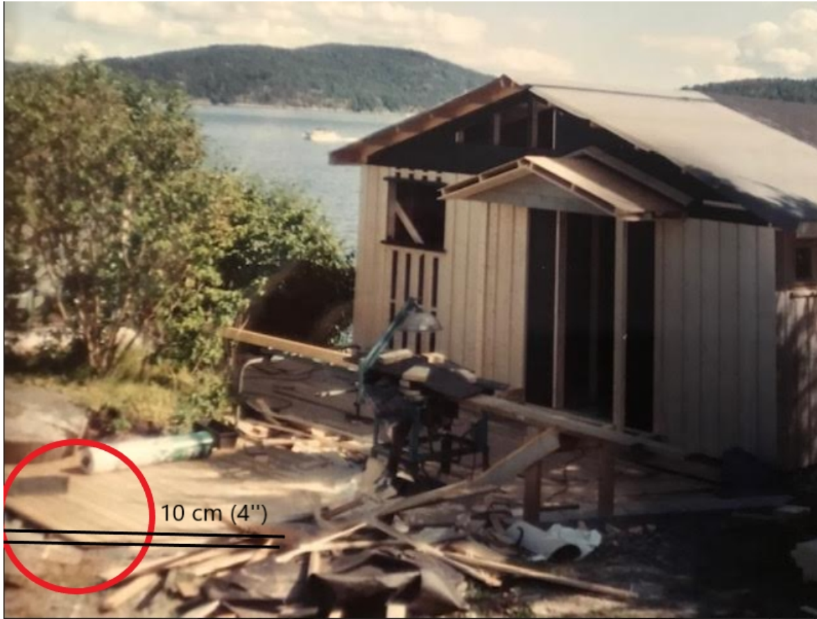
Bilde 5: Platting består av 28 mm terrassebord på 4" tilfarere på terreng, evt over settesand der nødvendig. Se Bilde 4 og 5 over.
