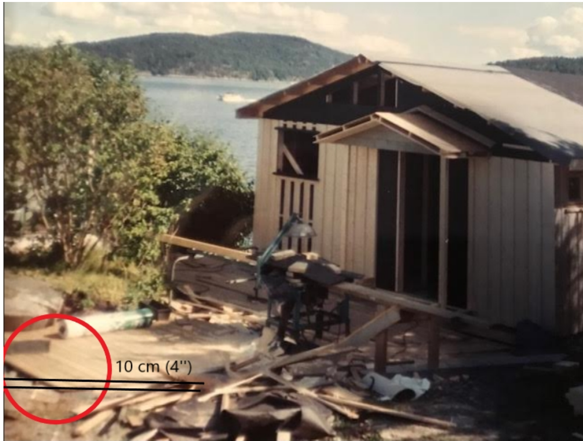
Bilde 5: Platting består av 28 mm terrassebord på 4" tilfarere på terreng, evt over settesand der nødvendig. Se Bilde 4 og 5 over.
