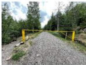
Figur 3.5.1: Bom ved starten av Stikkvannsveien
