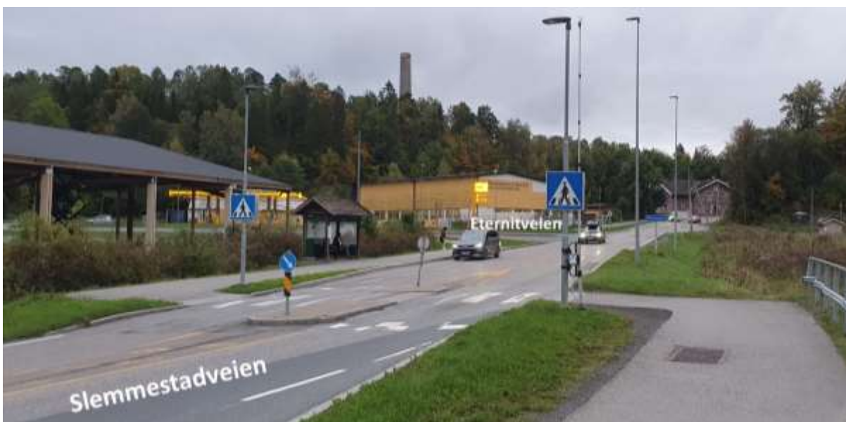
Figur 2-6: Slemmestadveien mellom Almedalsveien og Eternitveien. (Foto: Sweco Norge AS, 2023)
