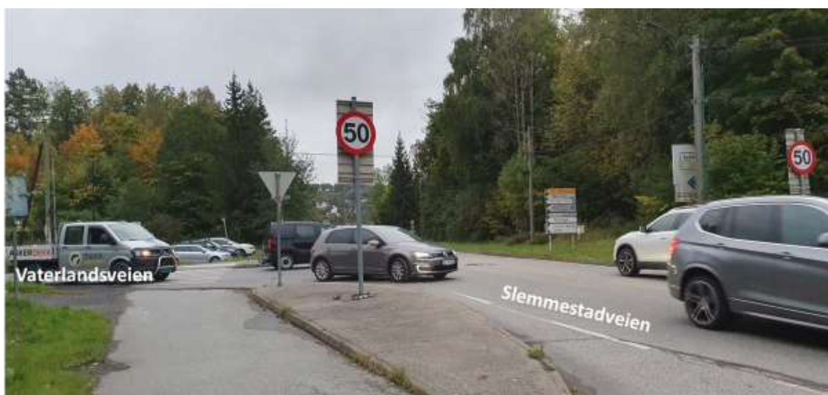
Figur 2-10: Vikepliktsregulert T-kryss Slemmestadveien X Vaterlandsveien (Foto: Sweco Norge AS, 2023)
