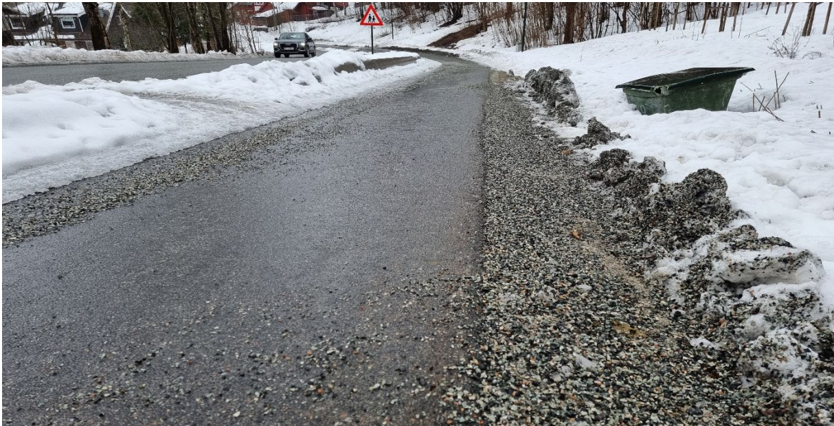
Figur 14 Mye av strøgrusen havner i grøftene og bidrar over tid til tetting av grøftene. Foto: Mari Gabrielsen
