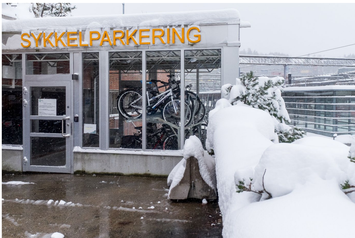
Figur 3133 Grindegården sykkelparkering ved Asker stasjon. Foto: Tove Lauluten.
