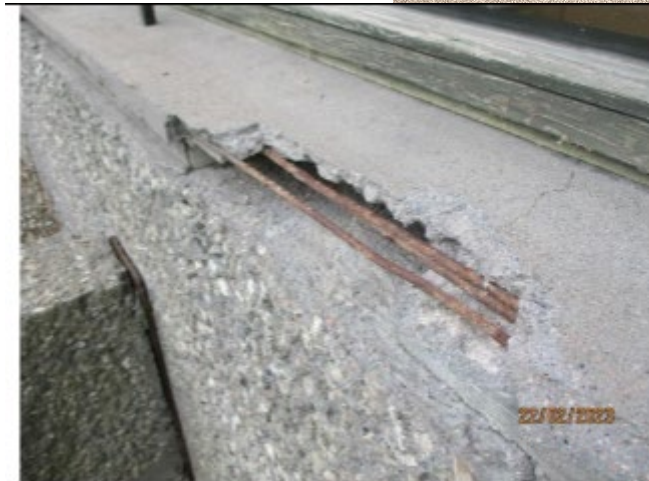
Bilde av åpen armering under et vindu.
