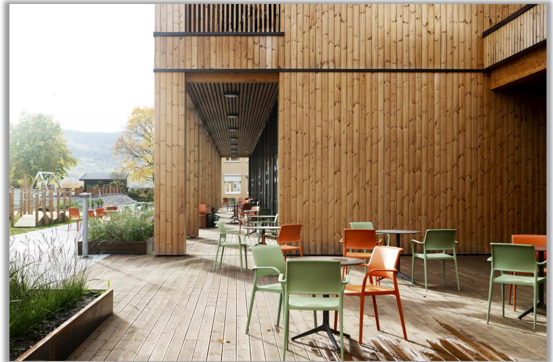
Inngangsparti/kafé ved Hovlitunet omsorgssenter, Søndre Land.
