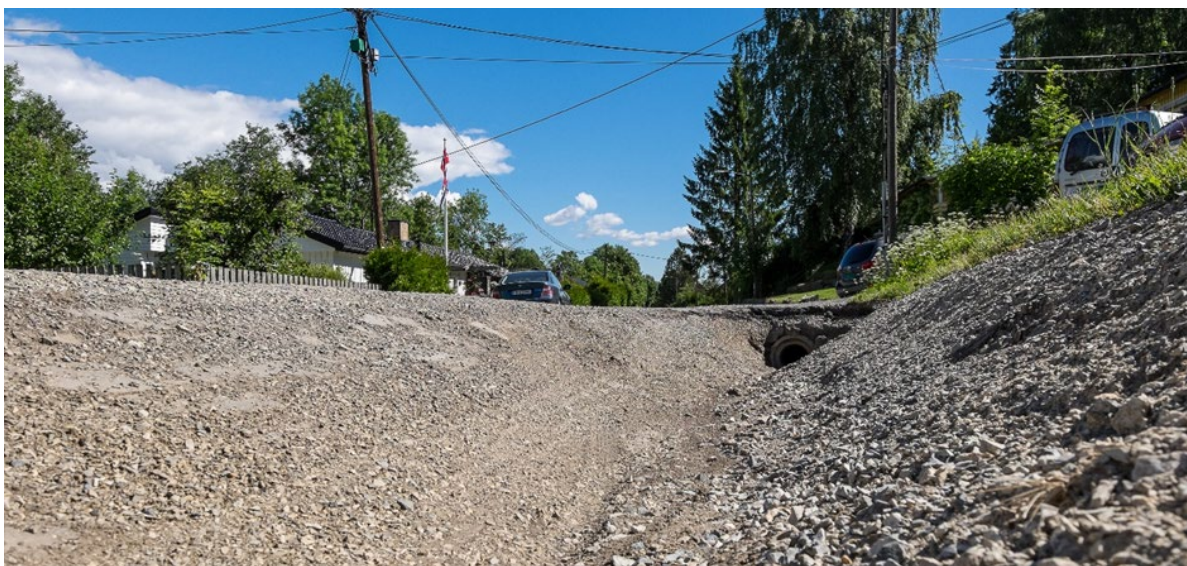
Figur 10 Rehabiliterert grøft. Foto: Tove Lauluten
