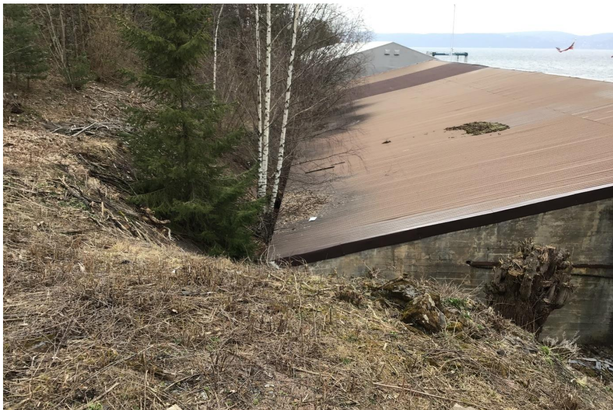
Figur 4: Kontorbygningens plassering i forhold til terrenget sett i fra vest mot øst.
