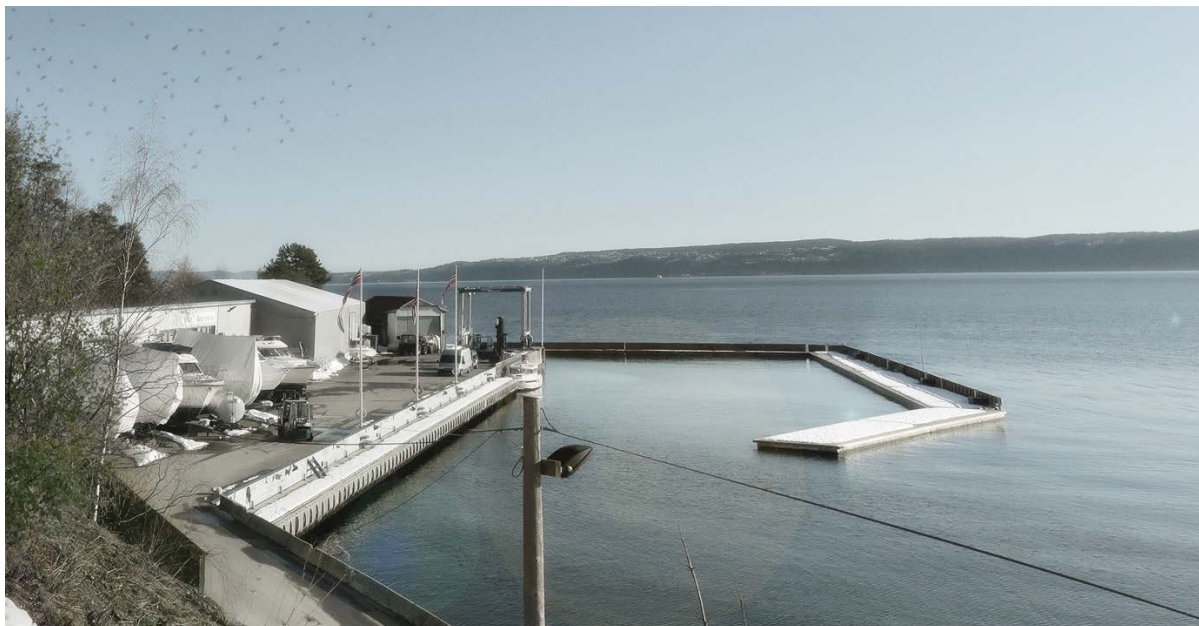
Fig 20: Bjerksåsholmen 115 sett fra vest. Eksisterende situasjon
