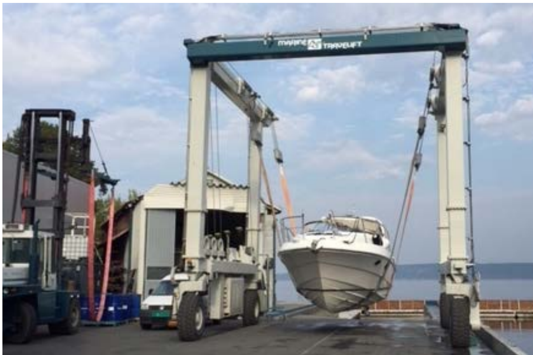
Fig 9: Eksisterende mobilkran som brukes til å heise båter opp og ned fra vannet. Mobilkranen løfter båter opp fra vannet og flytter dem til ønsket plassering for reparasjon på land. Båter blir enten lagt på bukker på land eller andre liftmaskiner som frakter båtene inn i den midlertidige plashallen.
