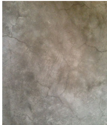
Betongtekstur eller fasadepuss med betonguttrykk
