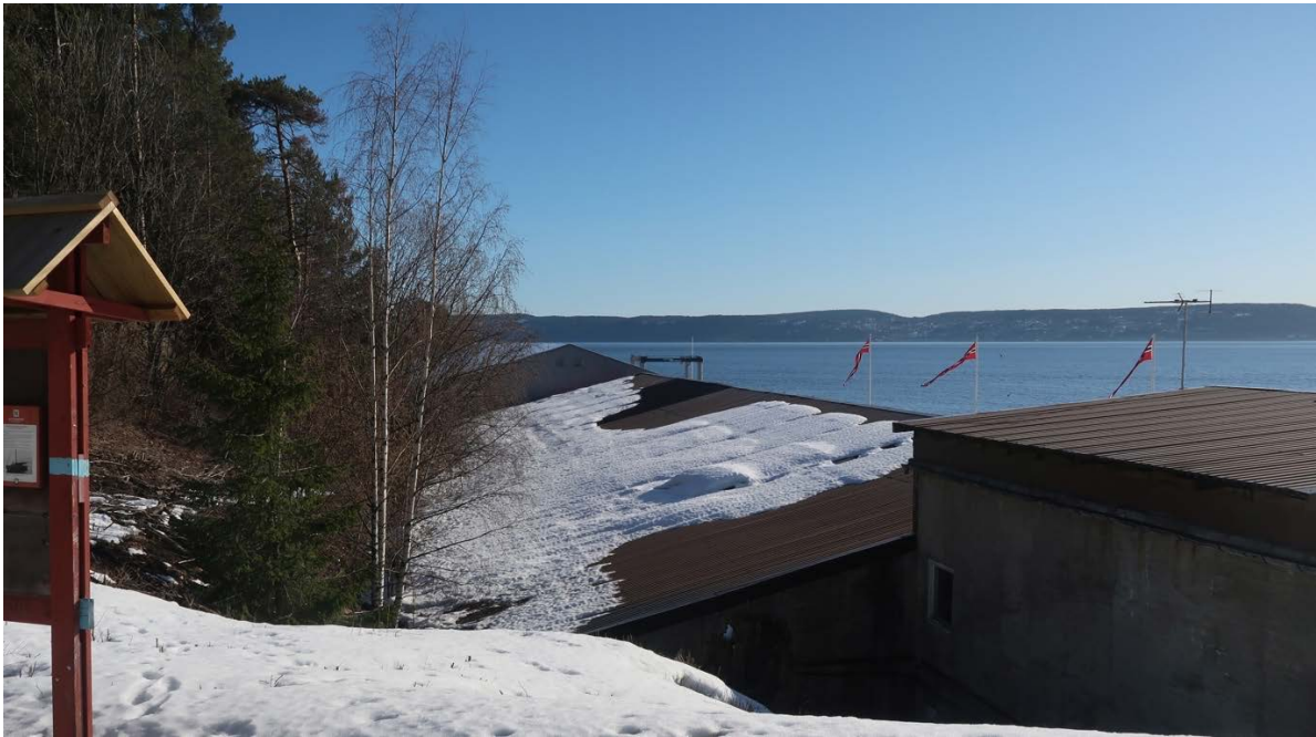
Fig. 23: Bebyggelsen sett fra vest, hvor man ser at det er mange høye trær på nordsiden av den eksisterende bebyggelsen.
