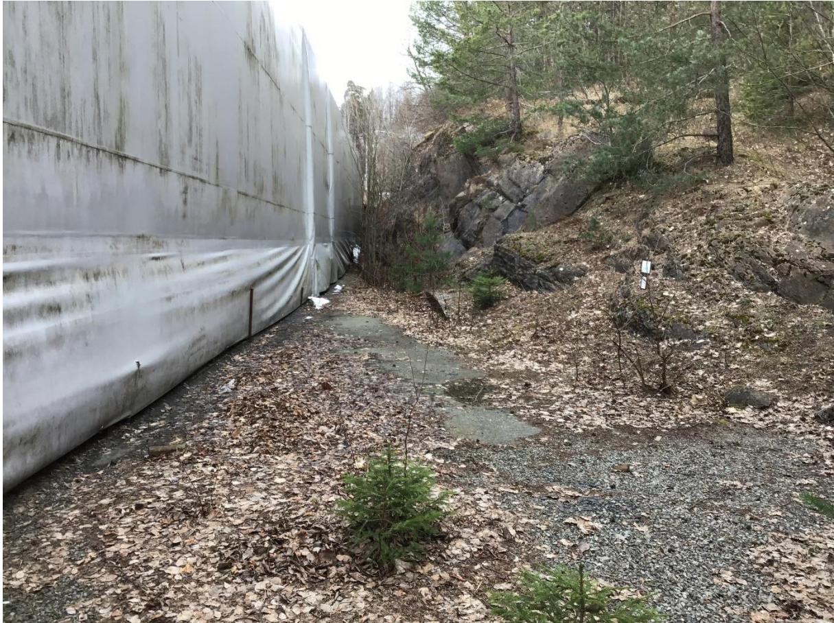
Figur 5: Kileformet asfaltert platting bak plasthallens østre del. Merk skilt om naturreservat i midtre-høyre del av bildet.
