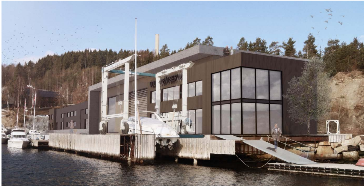
Fig 22: Bjerkåsholmen 115, med nytt kontorbygg med takterrasse og uteoppholdsområde på kaia.
