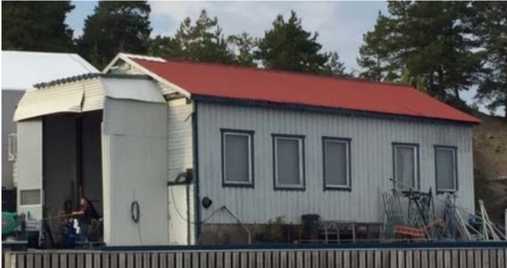
Fig 10: Eksisterende verkstedbygning. Bygningen står utenfor byggegrensen. Bygningen brukes til å ha en og en båt inne for reparasjon, men er meget slitt og det lekker inn vann, men er en nødvendig ressurs for å reparere mindre båter under tak.
