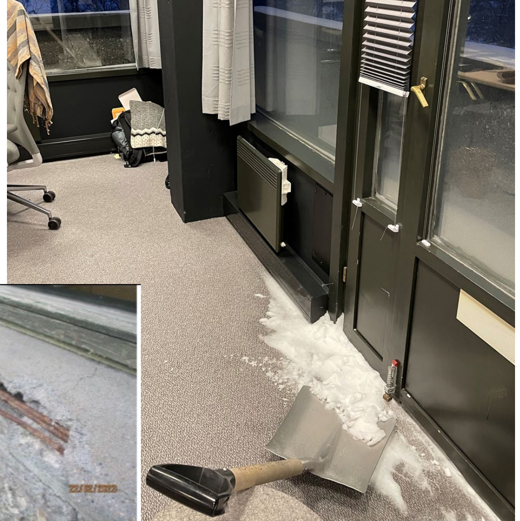
Bilde av åpen armering under et vindu.
