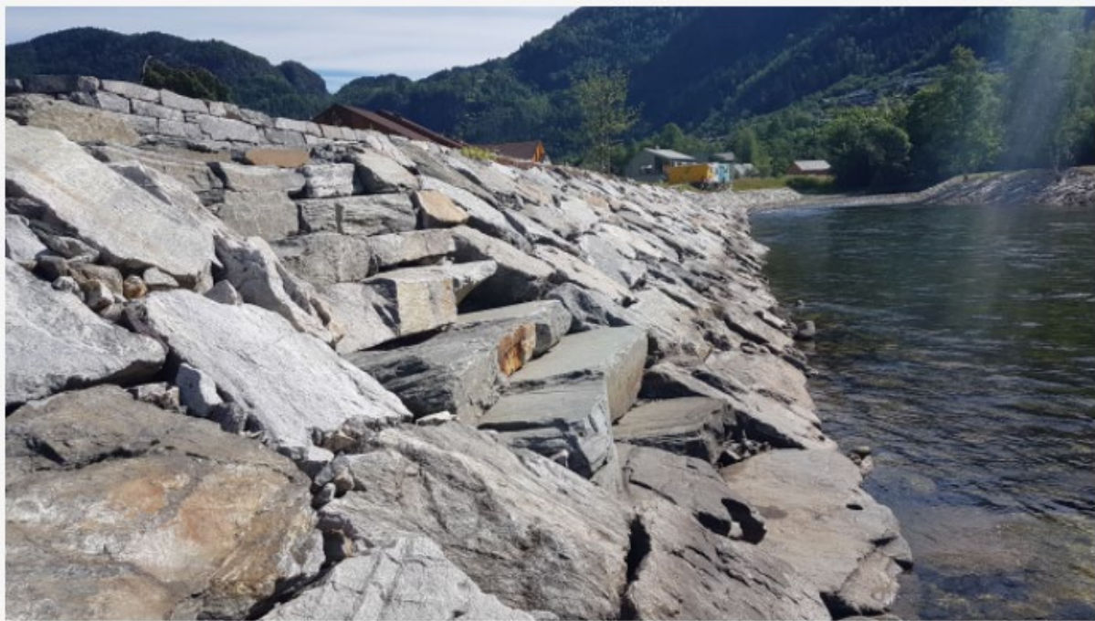
Figur 28 Eksempel på plastring som erosjonssikring, med trapp som gir mulighet til å komme ned til vannkanten. Kilde: Modul F2.203: Plastring – Prosjektering, NVE
