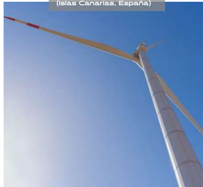
Parque eólico La Florida 3 (Islas Canarias, España)
