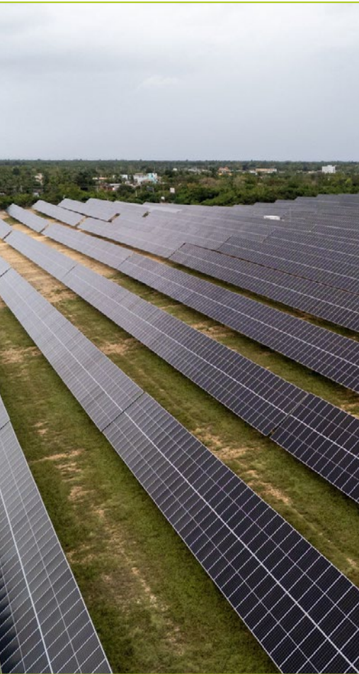
Detalle planta fotovoltaica en República Dominicana
