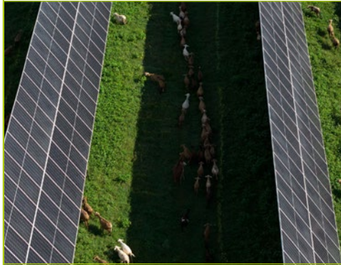
Detalle planta fotovoltaica en República Dominicana
