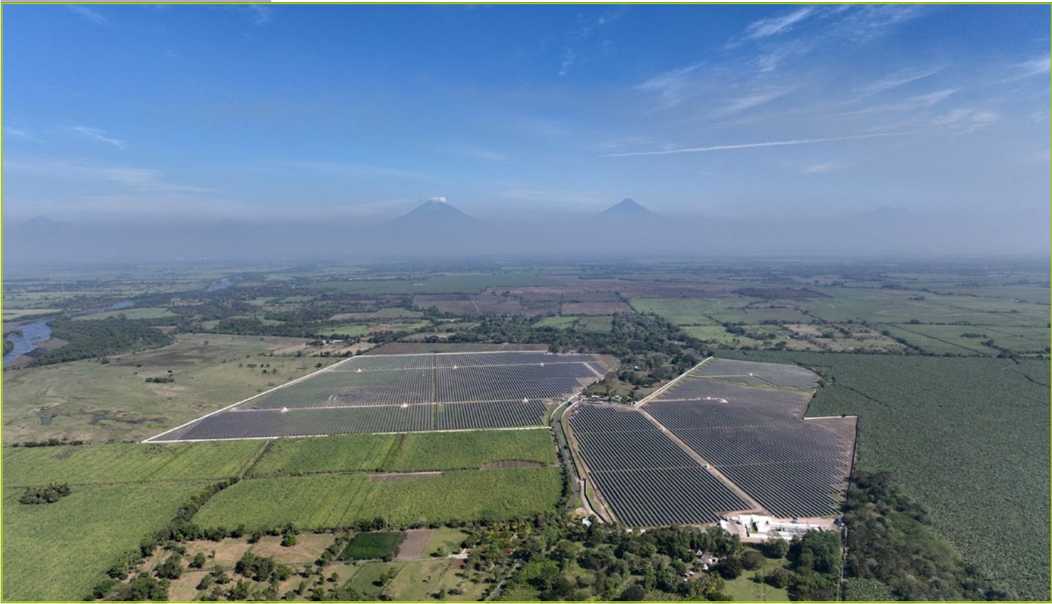
Planta fotovoltaica Yolanda (Escuintla, Guatemala)
