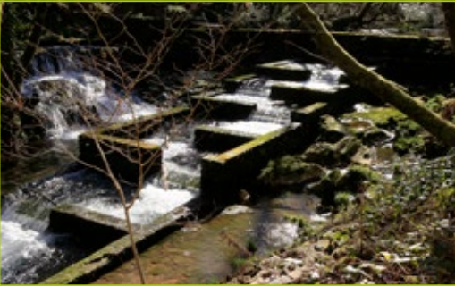
Escala de peces de la central hidráulica San Bartolomé (Galicia, España)
