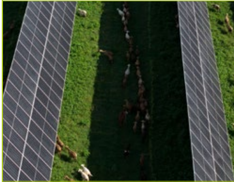
Detalle planta fotovoltaica en República Dominicana
