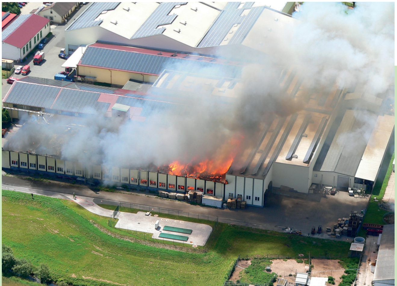
Brennendes Gebäude mit PV-Anlage
