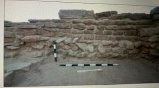
اللوحة رقم (٥): النوع الأول من الأساسات. أساسات ذات اسطح مائلة ( من عمل الباحث )
