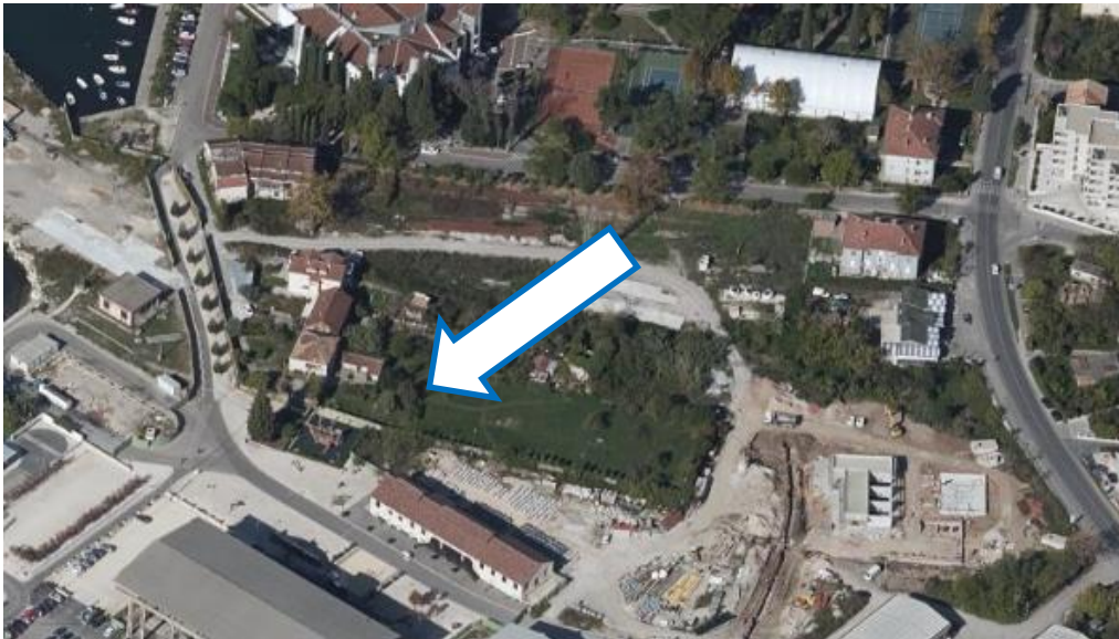
Slika 2.2. Pogled na lokaciju projekta
