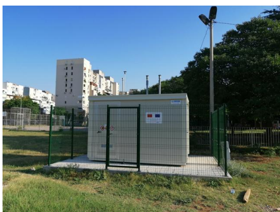
SLIKA 4 MJERNA STANICA BLOK V-PODGORICA
