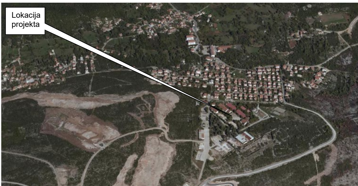
Slika 2.3. Pogled na lokaciju projekta
