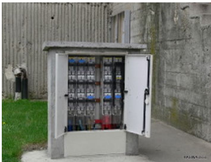
Slika. Izgled niskonaponskog razvodnog ormara sa 6 izvoda »NKRO6«
