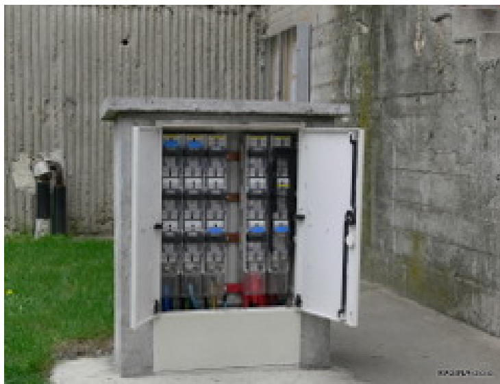
Slika. Izgled niskonaponskog razvodnog ormara sa 6 izvoda »NKRO6«
