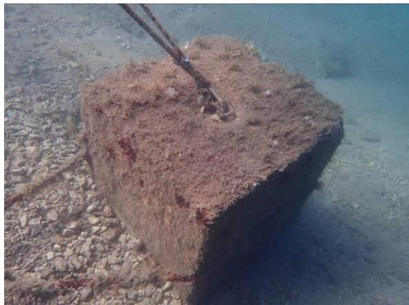
Betonski blok za bove kupališta i nasuti šljunak
