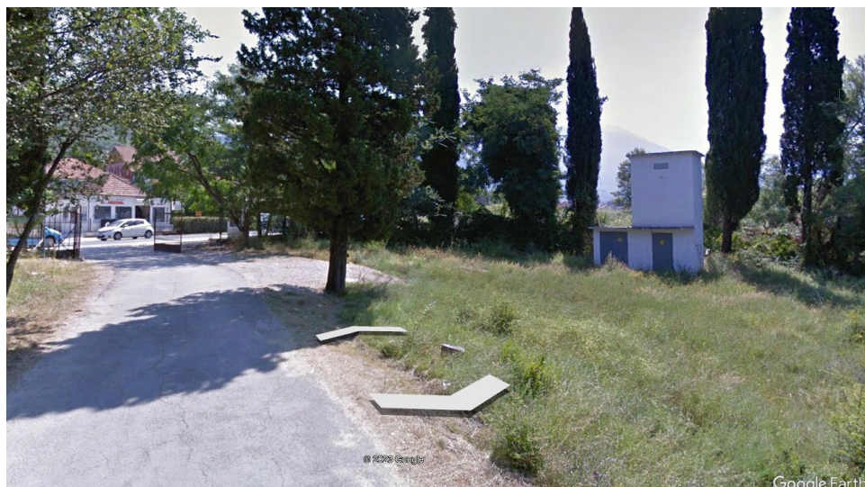
Slika 2.4. Polazna tačka kabla od postojeće TS 10/0.4kV "Župa"
