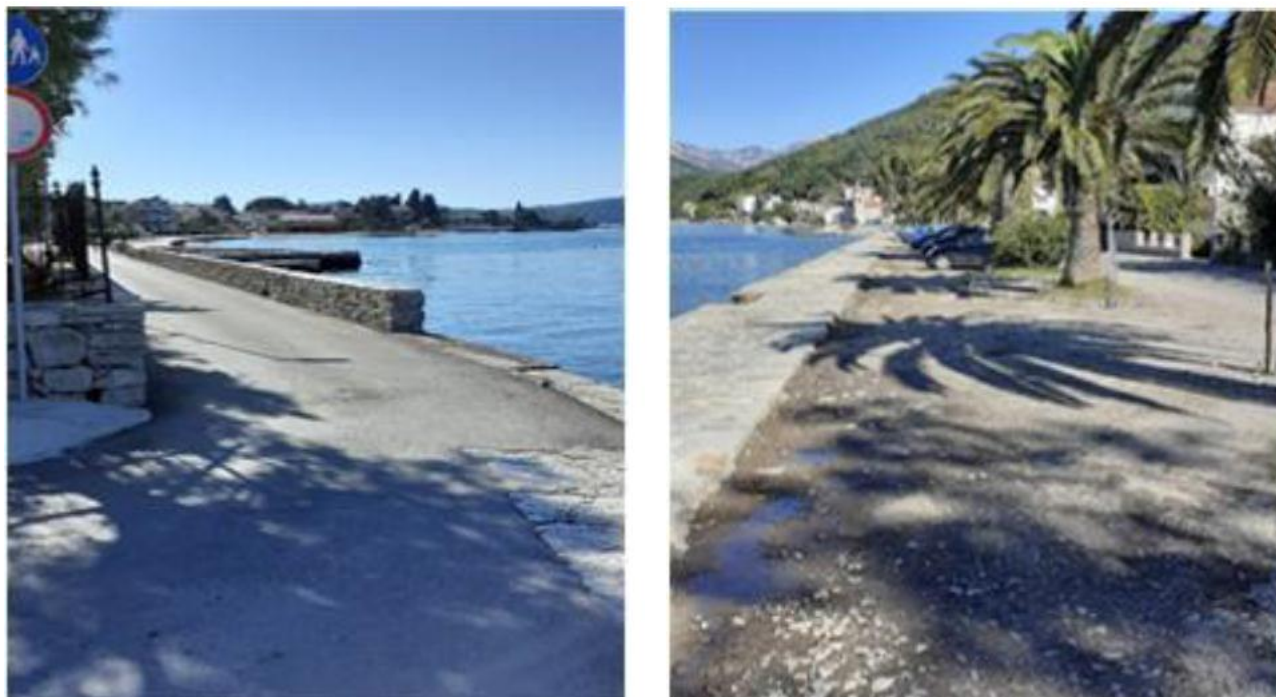
Slika 16. Lokacija pumpne stanice Donja Lastva
