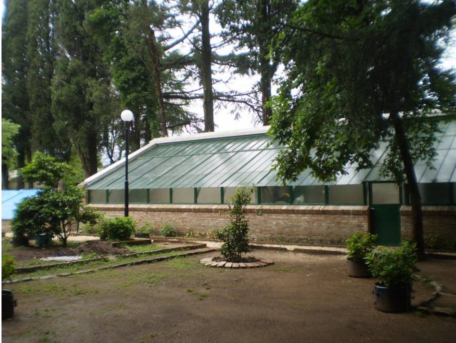
Slika 55. Izgled obnovljenog staklenika
