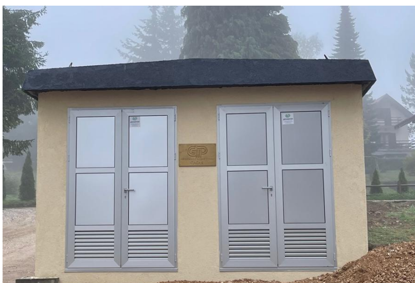
Slika 3.6. Primjer građevinskog objekta trafostanice
