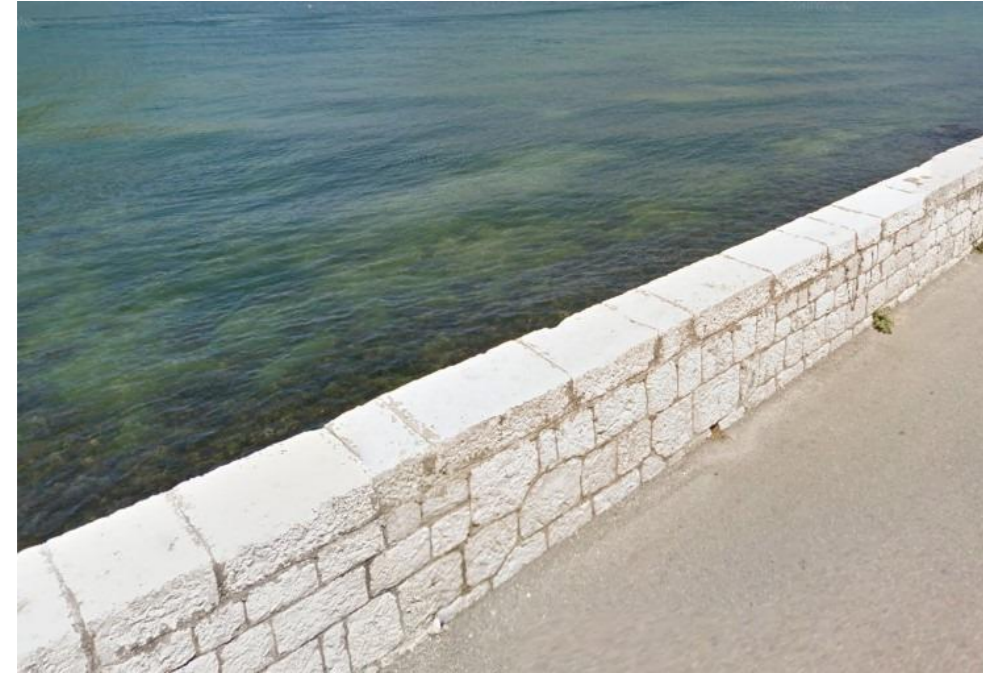
OIVIČENO ŠETALIŠTE Parapet - Upotreba lokalnog tradicionalnog kamena
