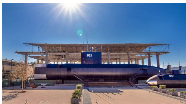
Slika 2.24. Nadstrešnica sinhro lifta i podmornica P821
