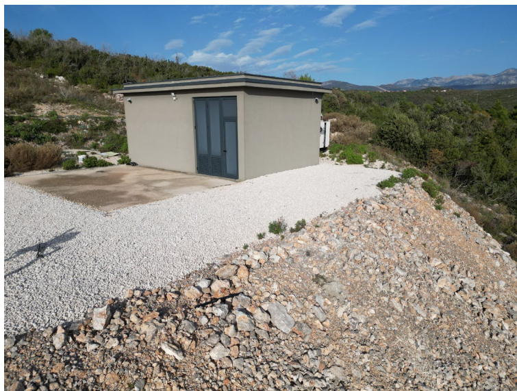
Slika 2.4. Izgled objekta u kojem će se realizovati projekat
