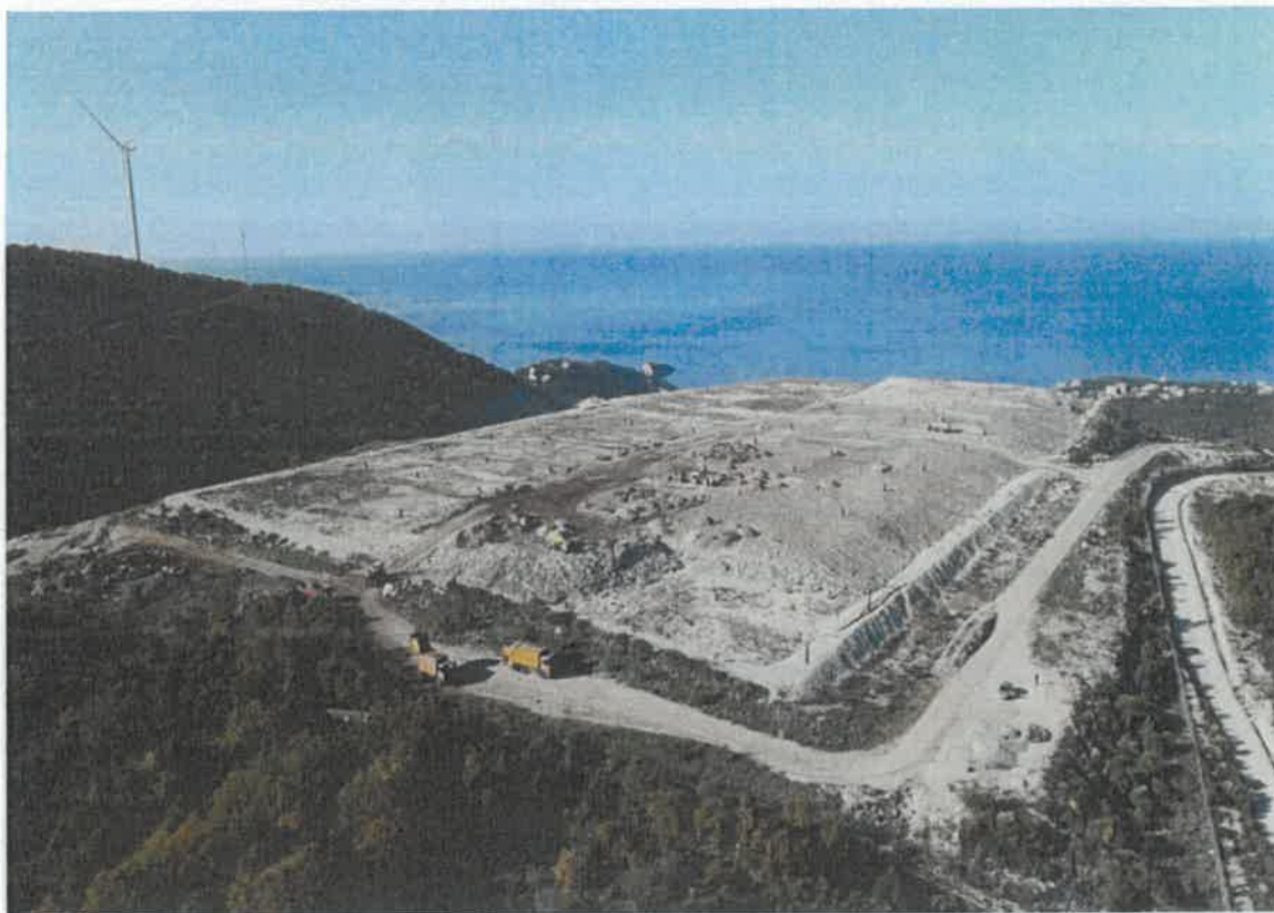
Slika 6. Lokacija regionalne sanitarne deponije „Možura“ na kojoj se odlaže komunalni otpad i sa teritorije Opštine Tivat
