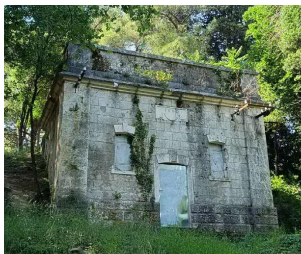
Slika broj 6. Pročelje austrougarskog rezeorvara za vodu
