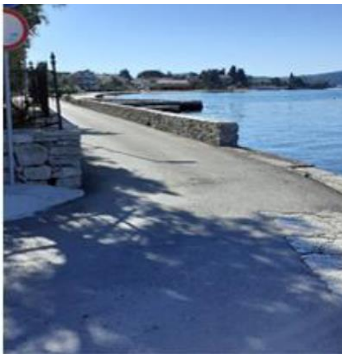
Slika 11. Lokacija pumpne stanice Donja Lastva
