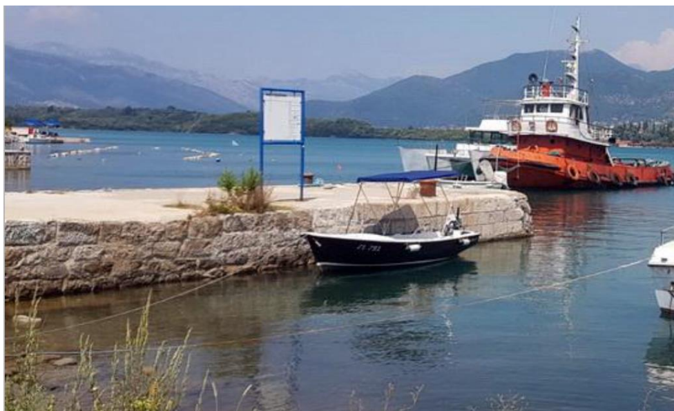
Slika 3. Postojeći izgled privezišta Bazdanj
